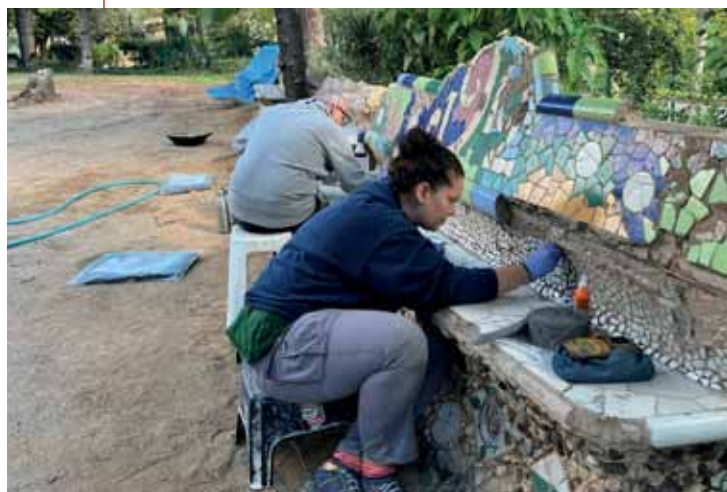
Treballs de restauració del Parc Sanitari Sant Joan de Déu
