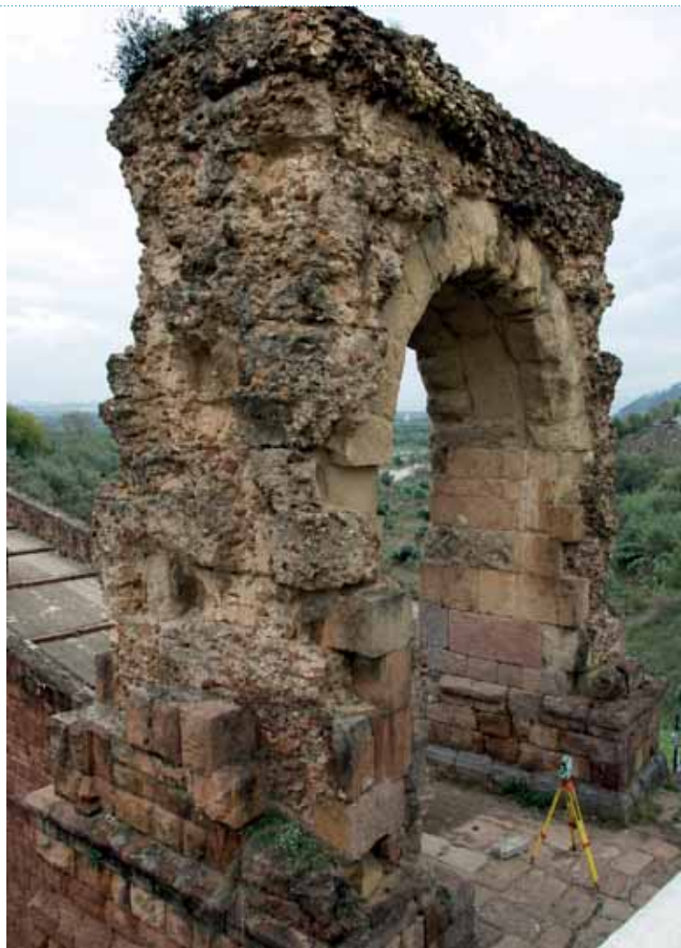
Arc romà situat a la part superior inicial del pont
