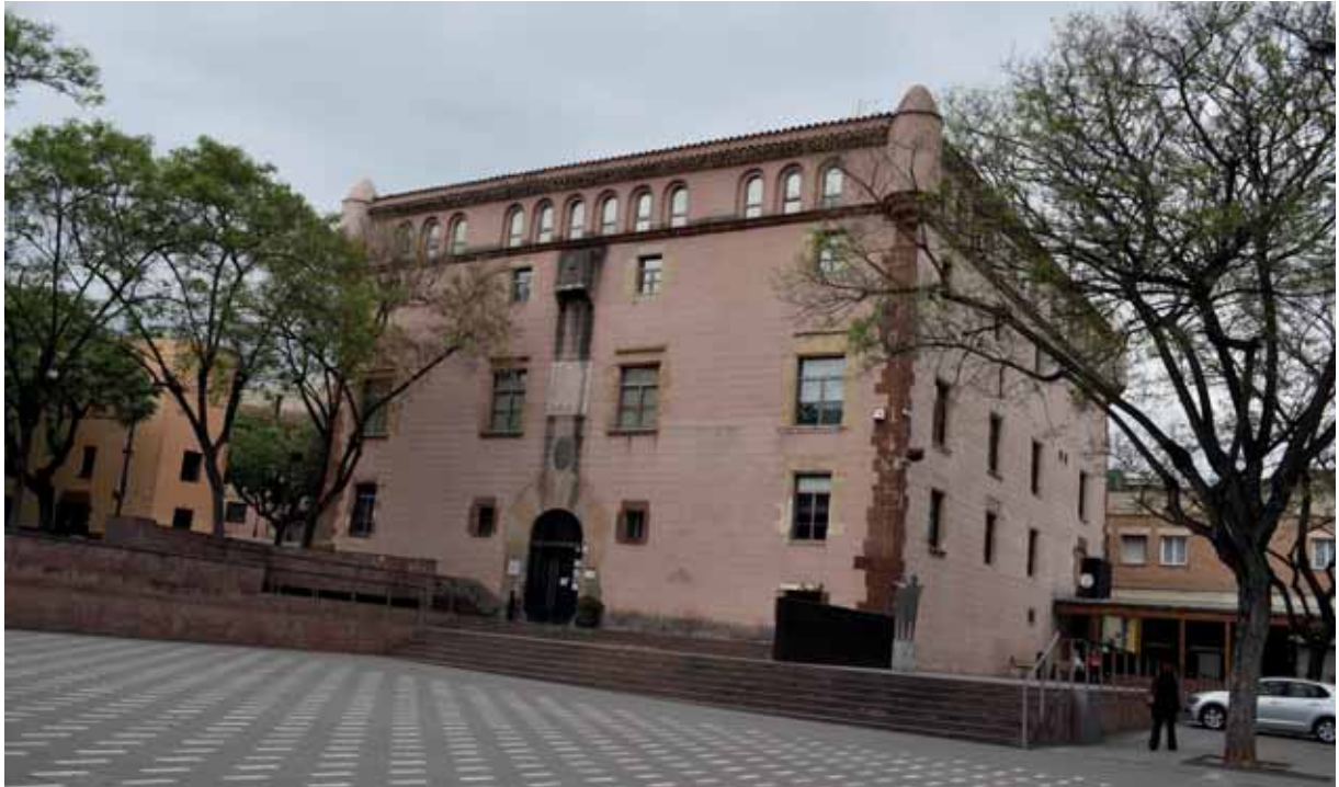
El Castell de Pallejà, construït el 1590 per Ramon Martí de Torrelles.
